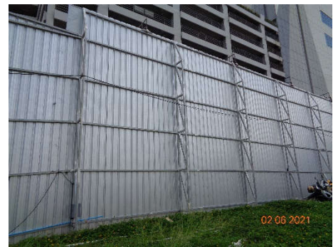
ภาพที่ 3.2.2-3 แนวรั้ว Metal Sheet ตามแนวเขตพื้นที่ก่อสร้าง
