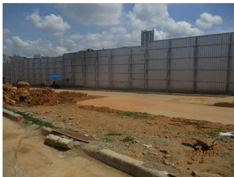
ภาพที่ 3.2.2-3 แนวรั้ว Metal Sheet ตามแนวเขตพื้นที่ก่อสร้าง
